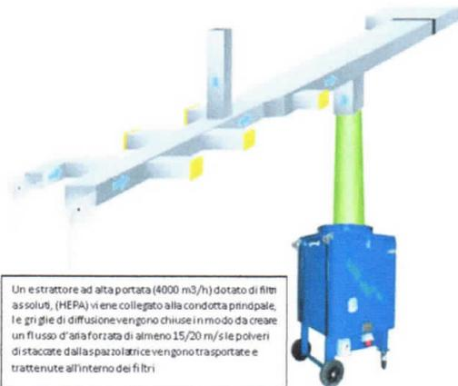
Un estrattore ad alta portata (4000 m<sup>3</sup>/h) dotato di filtri assoluti, (HEPA) viene collegato alla condotta principale. Le griglie di diffusione vengono chiuse in modo da creare un flusso d'aria forzata di almeno 15/20 m/s; le polveri di staccate dalla spazzolatrice vengono trasportate e trattenute all'interno dei filtri
